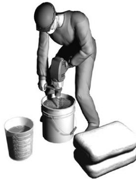
Figura 47 – Mistura do material de reparação [35]
