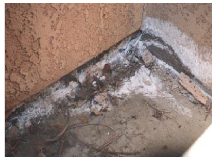
Figura 3 – Superfícies degradadas devido à acção de reacções sulfáticas de origem externa [5]
