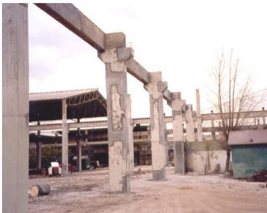
Figura 63 – Reposição do betão cortado com betão projectado nas faces dos pilares
