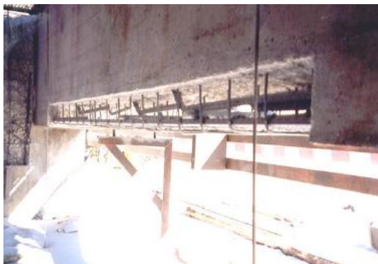
Figura 62 – Remoção do betão na envolvente das armaduras
