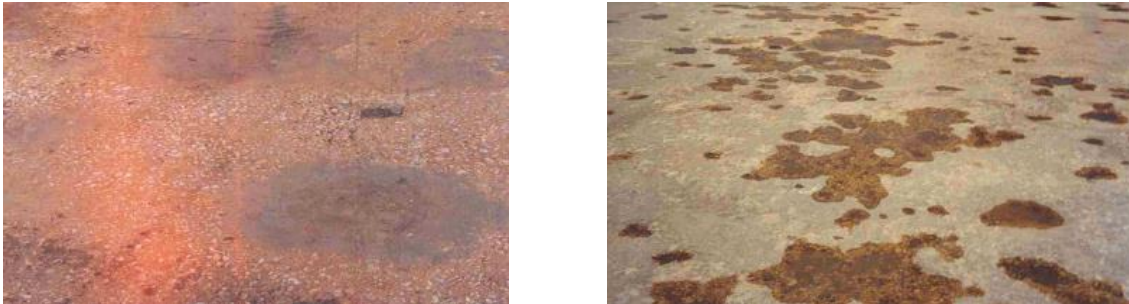
Figura 10 – Superfícies degradadas por abrasão [6]
