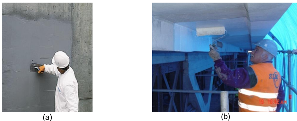
Figura 20 – Aplicação de um revestimento com [10]: (a) uma talocha e (b) um rolo
