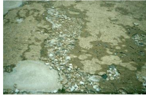
Figura 12 – Superfícies deterioradas pelos ciclos de gelo-degelo [6]
