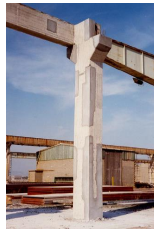
Figura 63 – Reposição do betão cortado com betão projectado nas faces dos pilares
