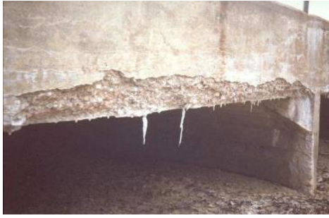
Figura 12 – Superfícies deterioradas pelos ciclos de gelo-degelo [6]
