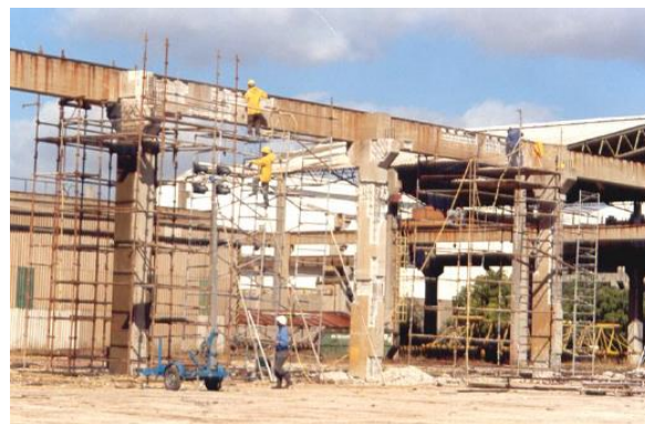
Figura 61 – Remoção do betão com martelo pneumático
