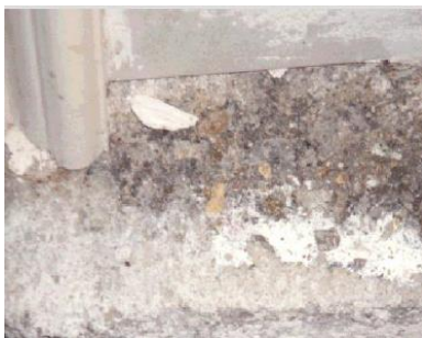
Figura 3 – Superfícies degradadas devido à acção de reacções sulfáticas de origem externa [5]
